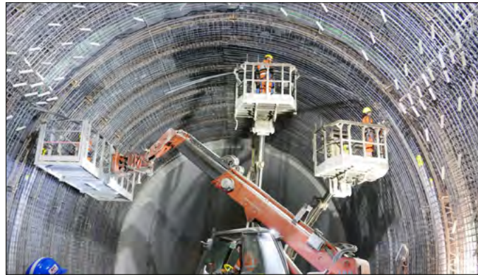
Besichtigung der Schalungsarbeiten im Tunnelstollen von Visp.
